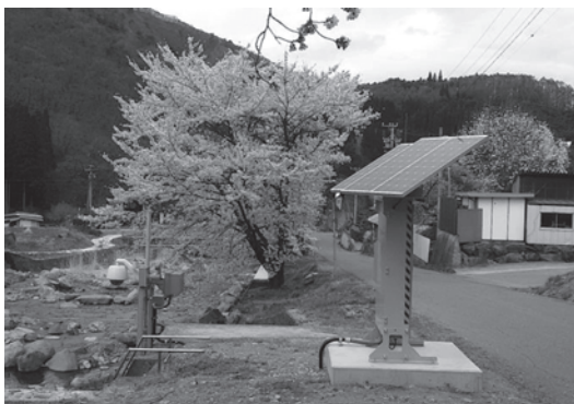
写真一八 本事例の設置状況
