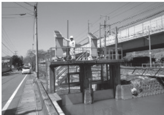
写真-1 水門開閉装置の外観
