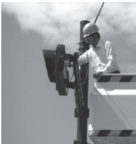
写真一三 信号機枠材の評価の様子 (館山市)
