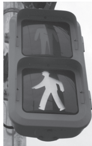
写真-2 千葉県銚子市で設置/運用している信号機の例 (F-②/P-②を塗装)
