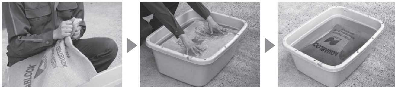
写真—8 吸水性土のうの製作手順
