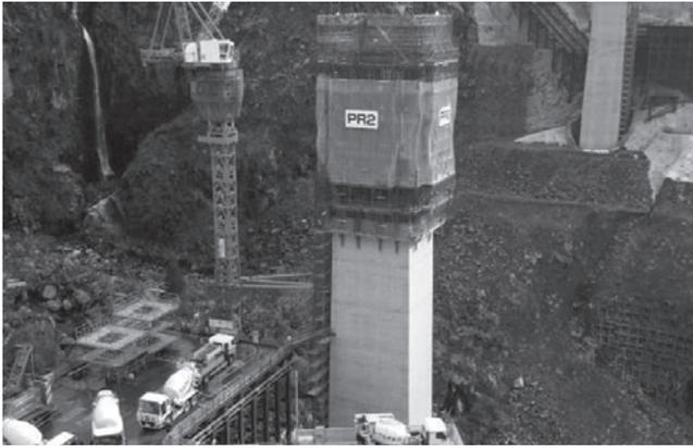
写真一六 ACSによる橋脚施工状況
