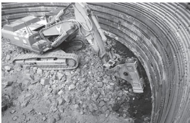
写真—5 大型掘削機（BH1.4 m³/3800 kg 級ブレーカ）
