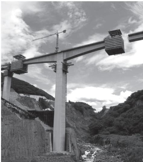
写真一九 張出架設, 終盤施工状況
