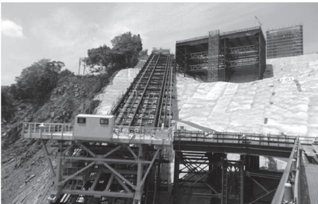
写真一 3 インクライン第三軌条方式
