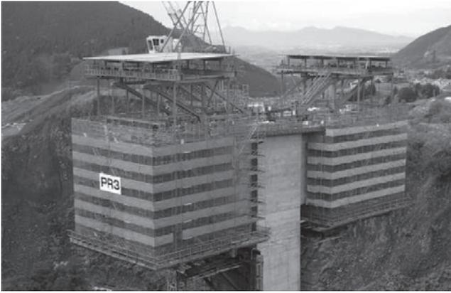
写真一八 超大型移動作業車による施工状況
