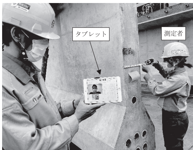
写真-1 「遠検」を利用した立会状況（現場）
