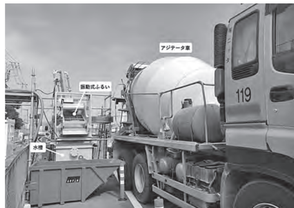
写真一3 アジテータ車からコンクリートを散水装置付き振動ふるいに入れている状況
