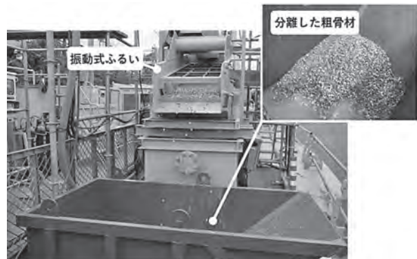
写真一2 散水装置付き振動ふるいの稼働状況
