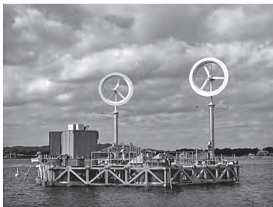
写真一2 博多湾プロジェクト(ステージI)18m直径の六角形コンクリート浮体。3kW レンズ風車2基と2kW 太陽光パネル搭載で計8kWのエネルギーファーム, 2011年12月。
