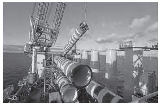
写真三3 フランジ式モノバイル用吊り具
