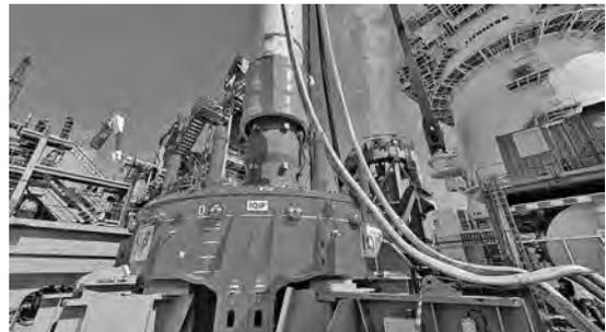
写真—15 水塊充填式騒音低減装置
