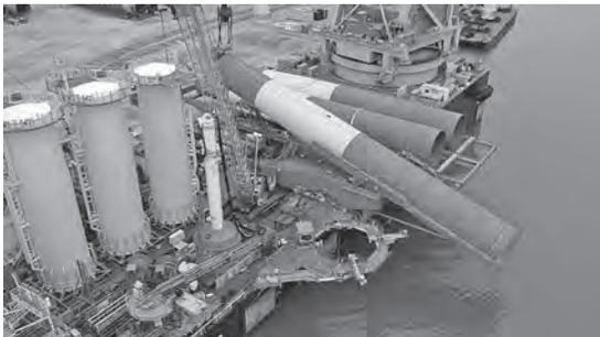
写真一4 作業船甲板に据え付けられた Up-ending Frame 集中荷重となるため、甲板強度の詳細な安全性検討が肝要
