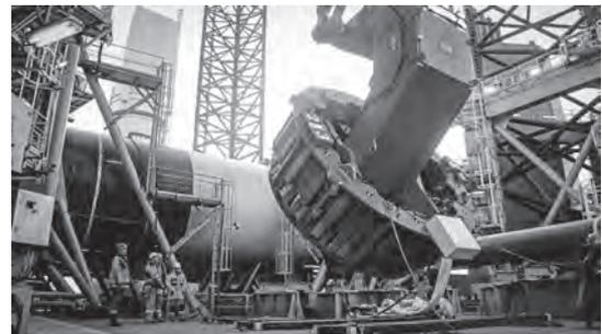
写真二2 グラウト式モノバイル用吊り具
