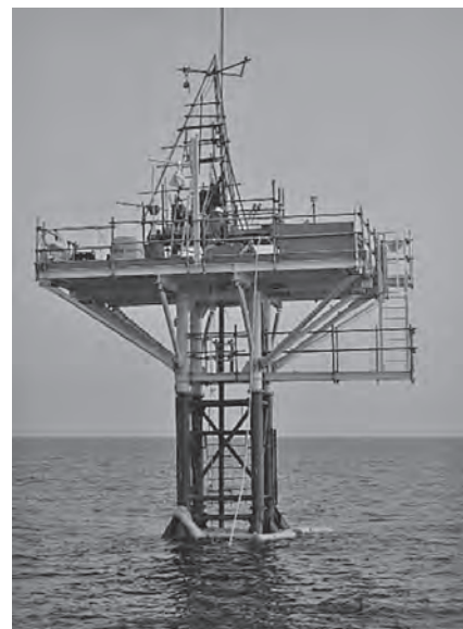
写真—1 自社製ボーリング用鋼製櫓（15基保有）
