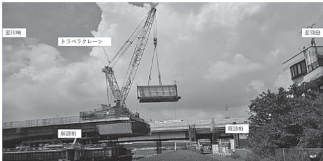
写真一3 トラベラクレーン架設状況
