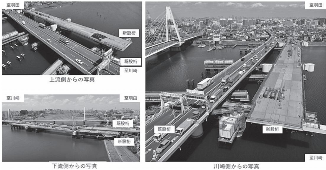
写真一 4 新設桁組立状況
