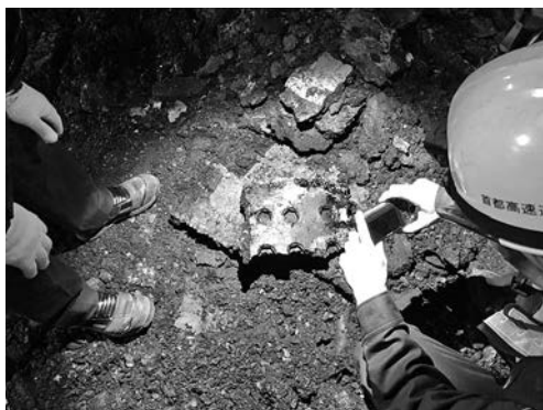
写真—5 添接部の既設ゲース撤去状況
