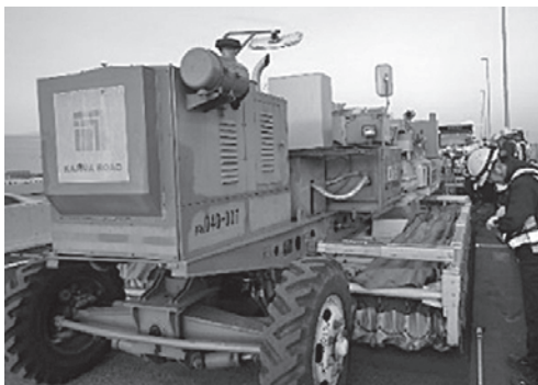
写真一3 ヒータ車による既設グース加熱状況
