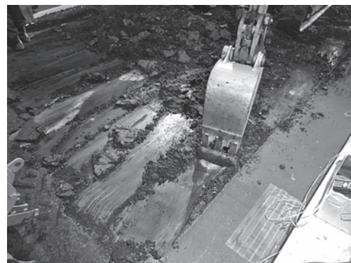
写真一4 平滑部の既設グース撤去状況
