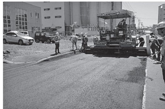
写真一七 施工状況
