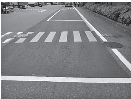
写真一四 状況写真 (事例①)
