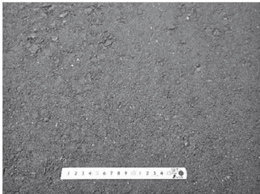
写真一五 舗装面写真
