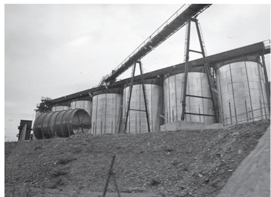
写真一九 骨材貯蔵ビン
