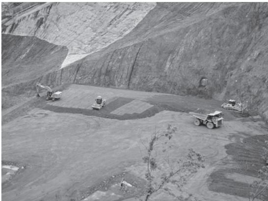
写真一六 堤体内部ロック施工
