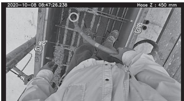
図-3 締固め位置解析例
