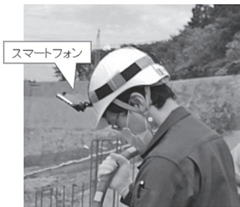
図-2 ウェアラブルカメラの設置状況
