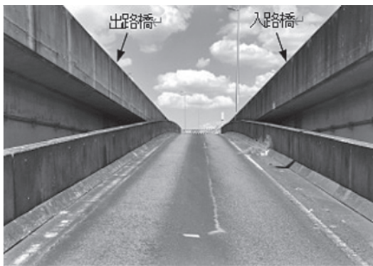
写真一 試験橋梁の施工前状況
