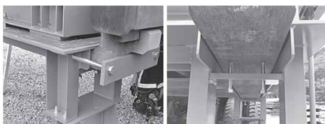
写真-6 心出し装置のフォークへの固定方法
