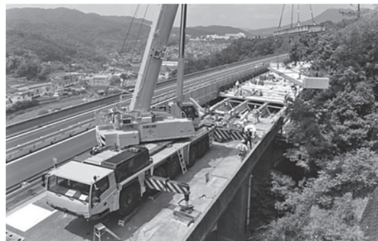
写真三 大型クレーンによる床版架設例
