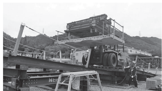
写真-7 実物大施工性確認試験実施状況
