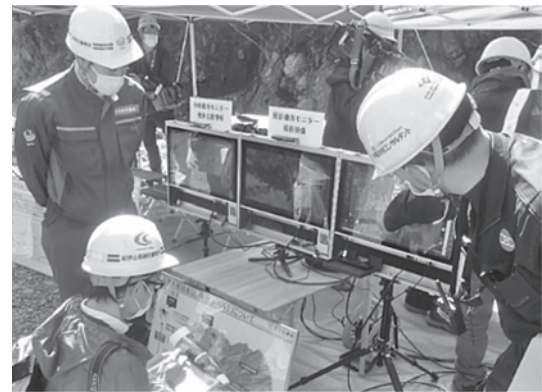
図-6 地上におけるリアルタイム映像確認
