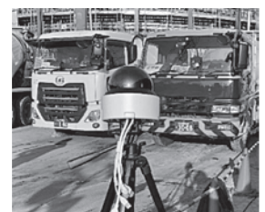
写真-1 ネットワークカメラによる打設開始・終了時刻の認識
