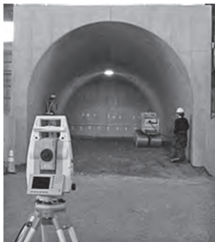
写真-3 TSを用いた検証試験状況
