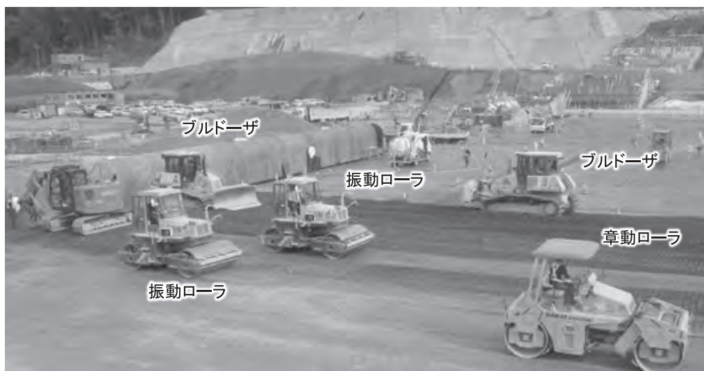
写真—1 ダム打設状況（台形 CSG ダム）
