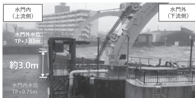
平成30年の台風第21号（9月）では、木津川水門が市街地の高潮浸水を防止。 写真—1 高潮から市街地を守る木津川水門（大阪府提供）
