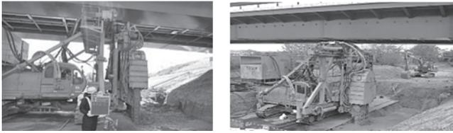
写真—5 橋梁下での低空頭施工機械
