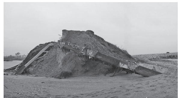
写真-2 津波・越波で破壊した堤防
