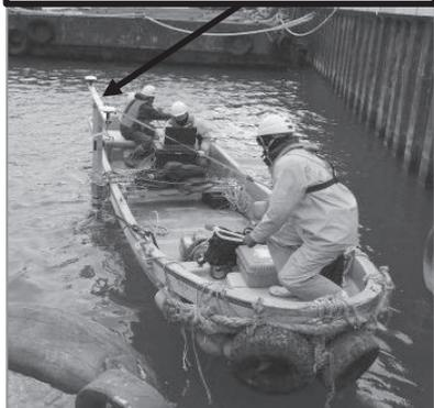
写真—1 測量船による深淺測量状況
