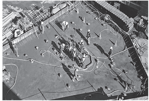
写真-3 浮上り防止筋施工状況
