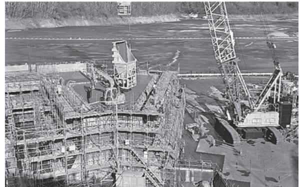
写真—5 流入部打設状況（水平バケット打設）
