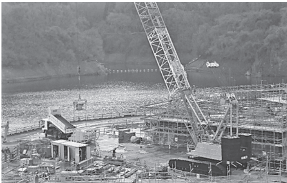
写真—4 流入部打設状況（通常ダンプでの積替）
