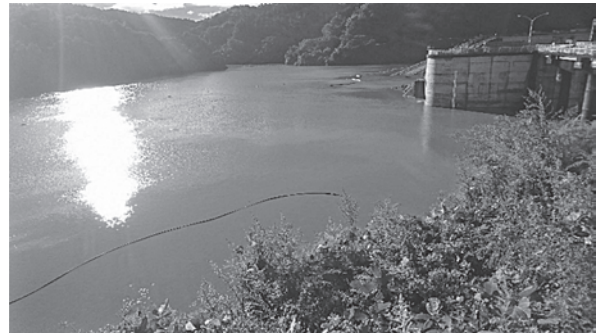
写真一一 R1年台風19号洪水 貯水池側
