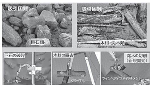
図-3 各種アタッチメントによる作業イメージ
