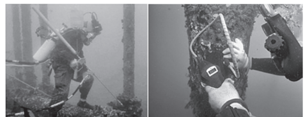
写真-2 高圧ジェットを使用した清掃 4) ・肉厚測定 5)
