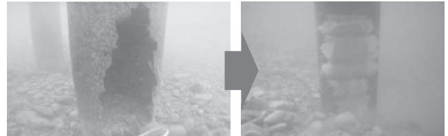
写真－5 併せて断面欠損部はグラウトを注入し応急対策
