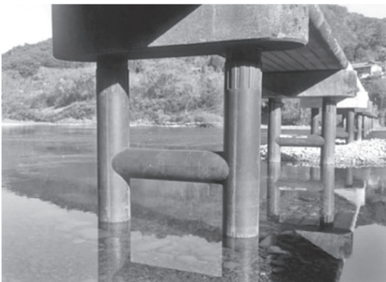
写真－3 鋼製当て板工法の採用
