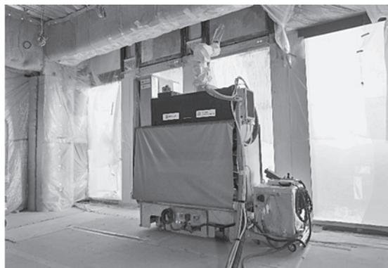
写真一4 耐火被覆取付ロボット
