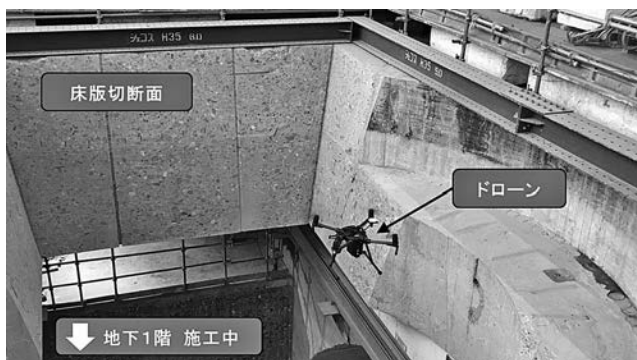
図一12 ドローンによるコンクリートの健全度確認
