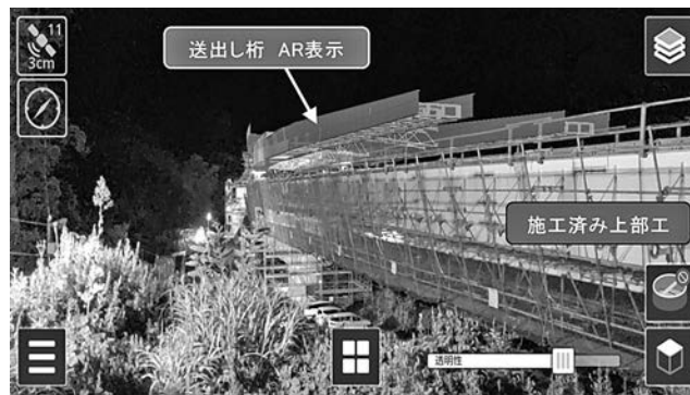
図一16 桁送り出し架設時のAR表示状況
