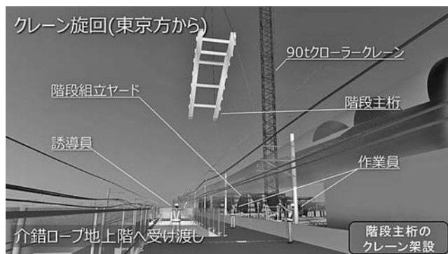
図四 階段主桁のクレーン架設動画
