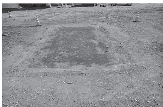
写真二 埋設管設置完了状況
