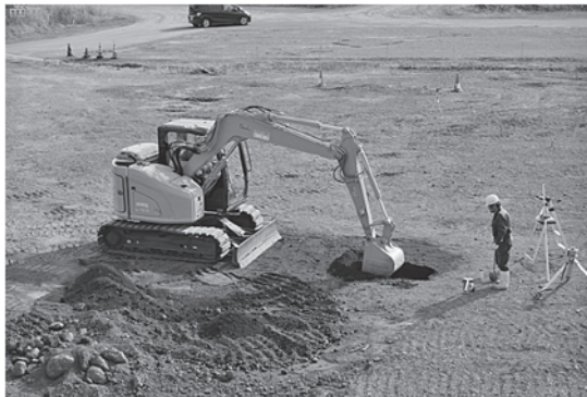
写真—5 従来建機による掘削作業
