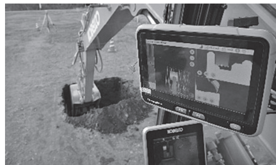
写真-4 ICT建機による掘削作業
