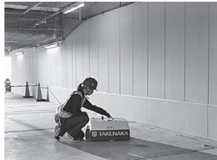
写真一七 墨出しロボット
