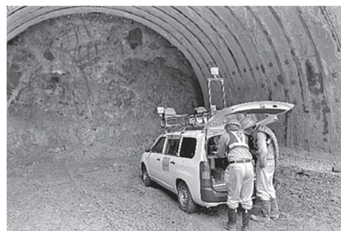
写真—2 切羽写真の取得状況
