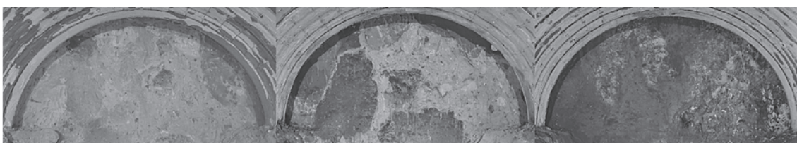
写真—1 凝灰角礫岩が分布する切羽写真の例
