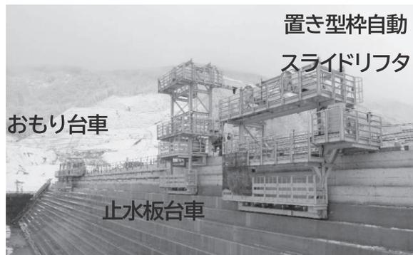
保護コンクリート構築の合理化施工システム
