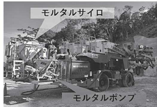
図-2 モルタル供給装置
