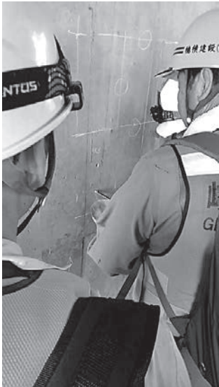
写真—5 コンクリート橋脚の中性化試験の様子
