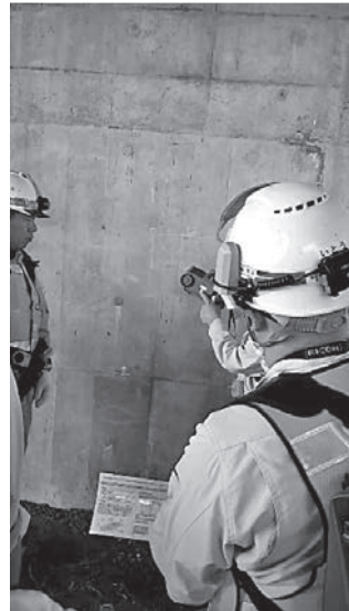
写真—6 コンクリート橋脚の鉄筋探査の様子
