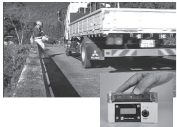
写真—8 加速度計を用いた橋梁のたわみ計測の様子
