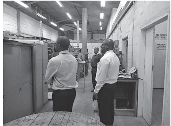
写真—7 ザンビア大学工学内の橋梁維持管理センター立ち上げのための改修スペース
