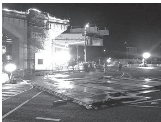
写真一2 不陸調整状況
