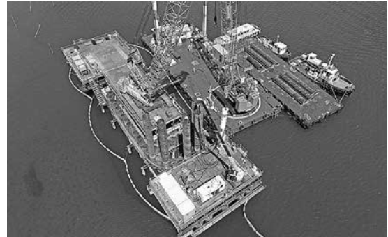
写真三 鋼管矢板打設状況
