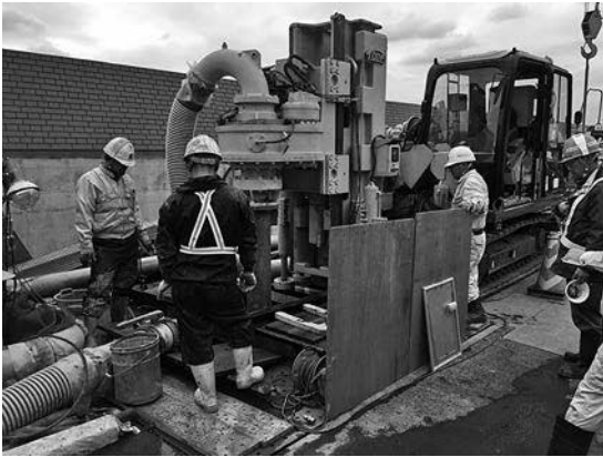
写真-10 階段工基礎（TBH工法）施工状況
