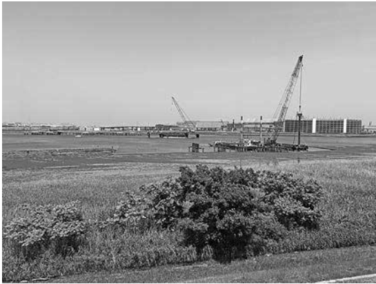
写真一 干潟浚渫部での施工状況
