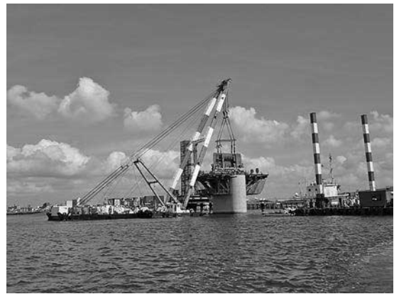
写真-5 柱頭部架設状況
