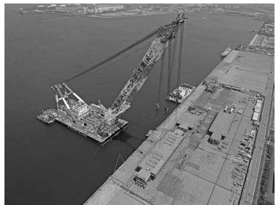
写真-6 浜出し状況
