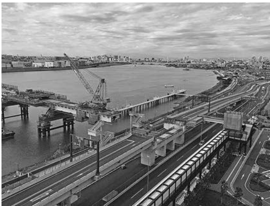
写真一八 東京側張出し架設状況
