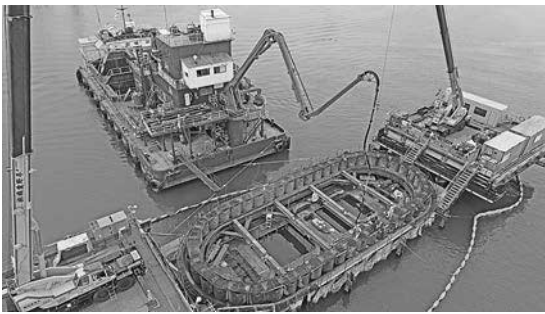
写真-4 コンクリート打設状況
