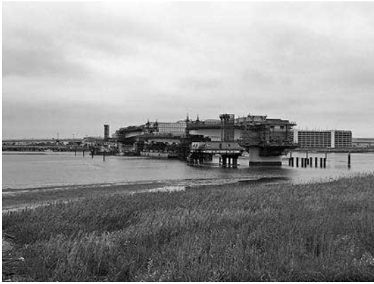
写真一七 台船吊上げ架設状況
