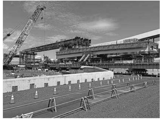
写真一九 送出し架設状況
