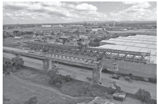
写真—4 LG架設状況
