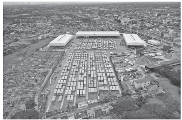
写真-1 セグメント製作ヤード
