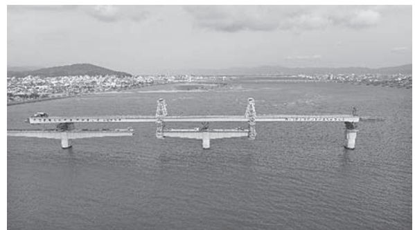
写真—2 架設桁による張出し架設
