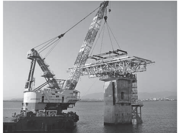
写真-3 エレクションノーズ設置状況
