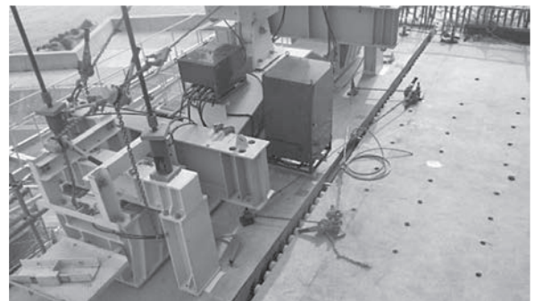
写真-4 基準セグメントの平面位置・高さセット状況
