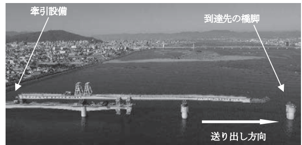
写真-5 送り出し状況
