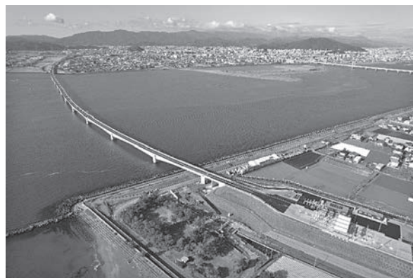
写真一 10 吉野川サンライズ大橋全景
