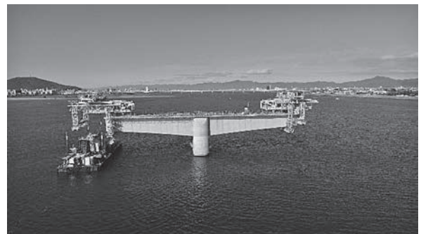
写真—1 エレクションノーズによる張出し架設
