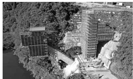
写真-4 斜吊り張出し架設
