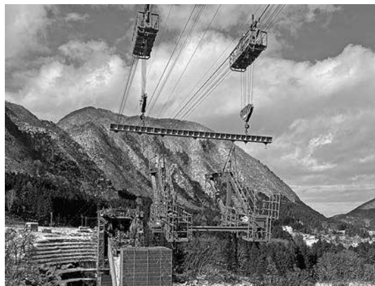
写真-5 移動作業車の大払い
