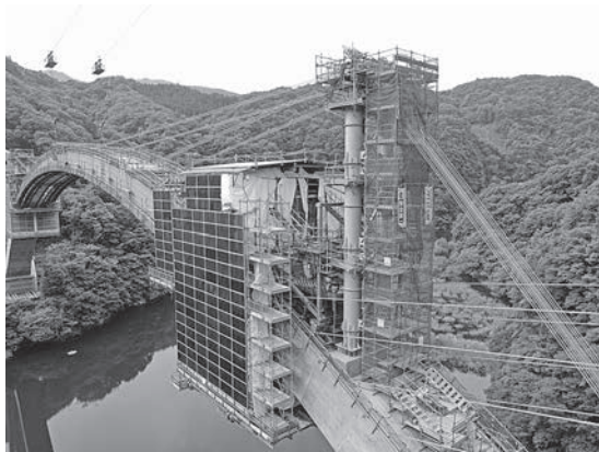
写真-6 鋼メラン材の架設
