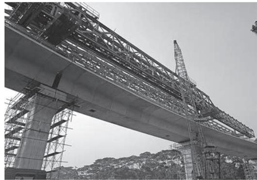
写真一1 スパンバイスパン架設完了状況
