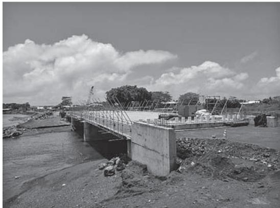
写真一 5 桁架設後
