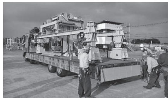
写真一1 架設機走行フレーム運搬
