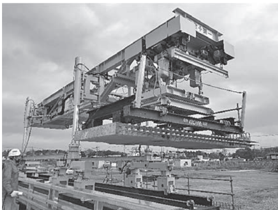
写真一 3 車載運搬型架設機での床版架設状況
