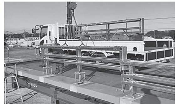
写真—7 施工安全性、サイクルタイム確認状況
