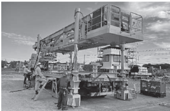
写真一 2 架設機上部本体フレーム運搬・組立
