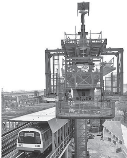
写真-8 鉄道橋バランスキャンチレバーハンガーフレーム
