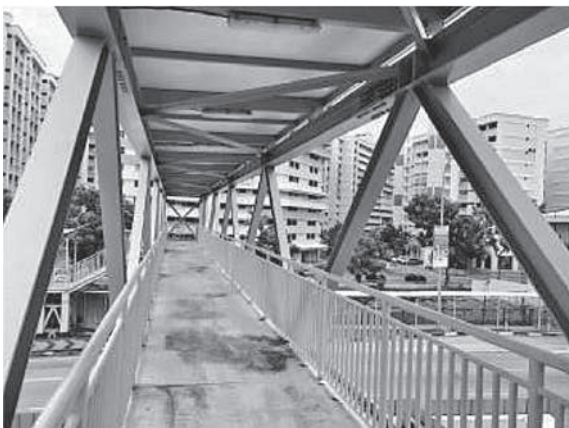
写真一4 上部トラス架構内 近景
