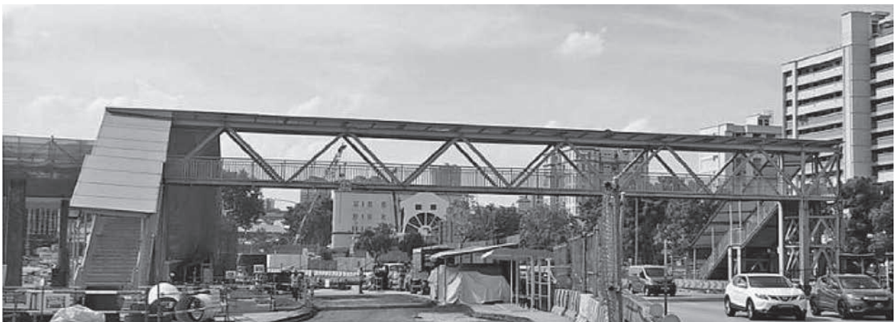
写真-2 仮設歩道橋 遠景
