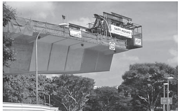
写真-13 道路橋のプレキャストバランスキャンチレバー移動式 PC 緊張吊り足場 (高速道路上部)
