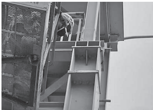
写真一 6 下部工接続部 確認状況
