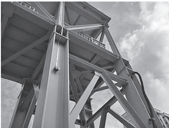
写真一3 下部工 近景
