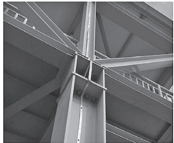
写真-5 下部工・上部工接合ボルト近景
