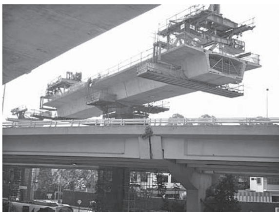
写真-10 道路橋の移動式 PC 緊張吊り足場
