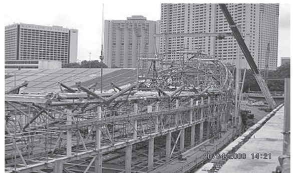
写真-14 ステンレスチール 2重らせん歩道橋の仮設門型クレーンと軌道支保 (海上)
