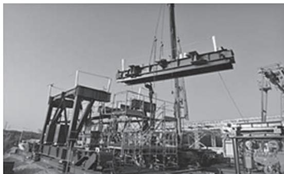
写真-10 主構（前方部）の搭載
