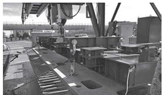
写真一 6 新設床版架設時の天秤構造
