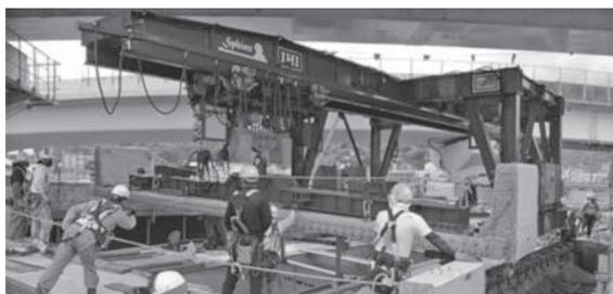
写真—15 新設床版架設作業
