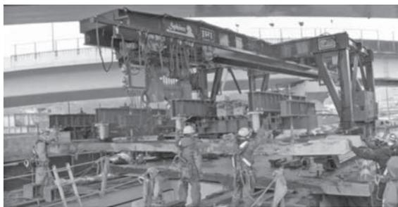
写真—14 旧床版撤去作業
