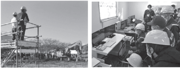
写真一三 遠隔施工の操作（直接目視と映像操作）
