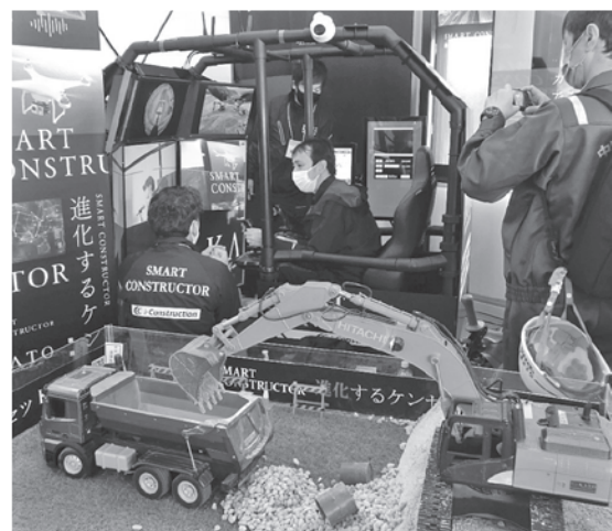
写真一六 模型を用いた遠隔施工
