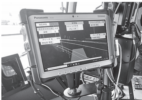
写真-2 自動制御装置
