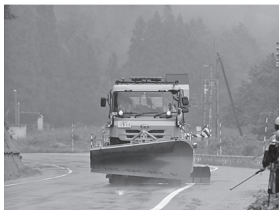
写真-5 降雪期前の現道試験実施状況(湯沢工区)
