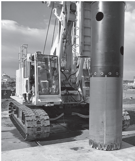
写真-2 ケーシング (φ1,000) 装着状態
