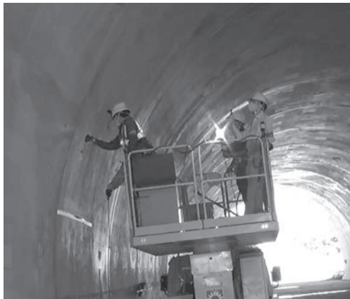
(a) 高所作業車による作業状況
