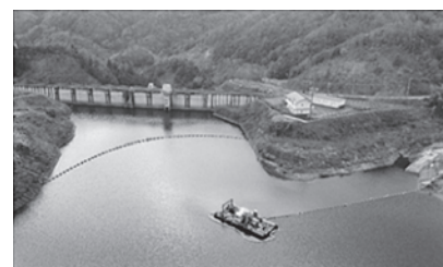
写真-2 ダム湖における施工
