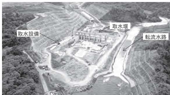
写真一 取水設備・取水堰・転流水路
