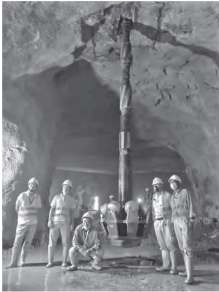
写真-5 レイズボーリングφ1.500mリーミングビット
