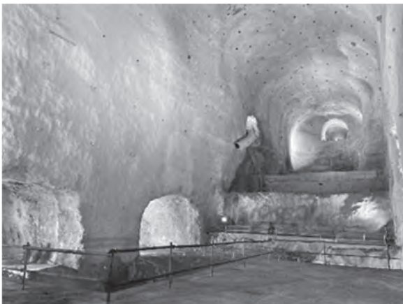
写真-3 地下発電所掘削完了
