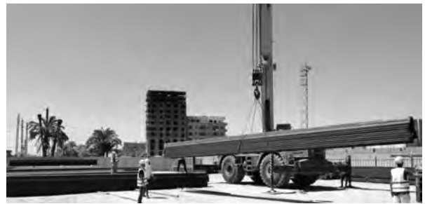
写真-2 現場荷卸し状況
