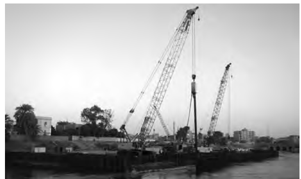
写真-4 二重締切り鋼矢板の打設状況
