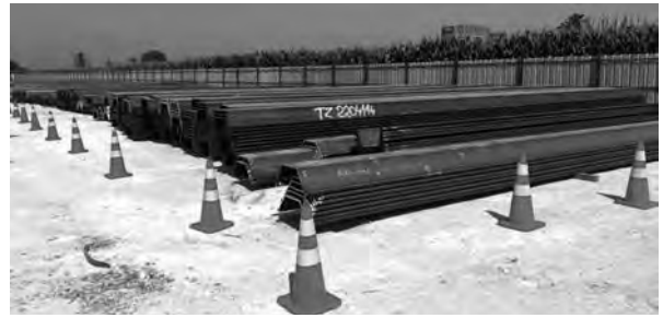
写真-3 現場搬入完了
